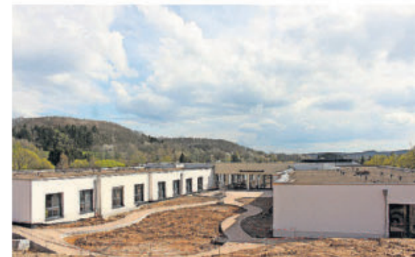
In drei Wochen soll auch die Außenanlage vor der neuen Senioreneinrichtung Haus Weiselberg in Oberkirchen fix und fertig sein.
