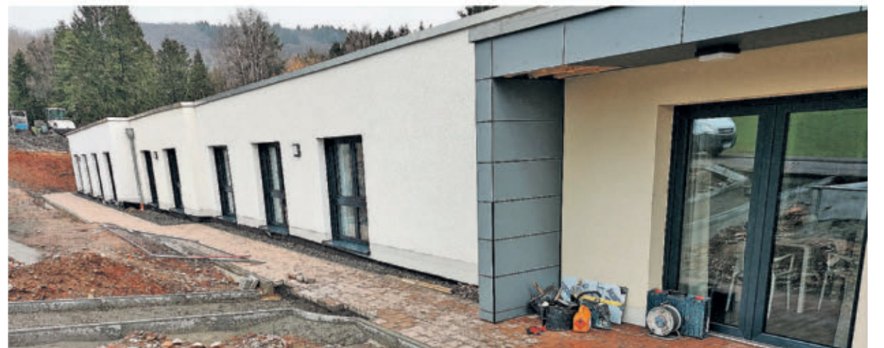
Die Wohnungen sind bereits einzugsbereit, an der Außenanlage muss noch gearbeitet werden.
