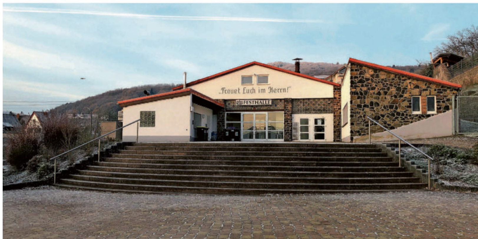
So sieht die Festhalle in Oberkirchen derzeit aus. Geplant ist, dass sie erneuert wird. Kosten: zwischen zweieinhalb und drei Millionen Euro.
