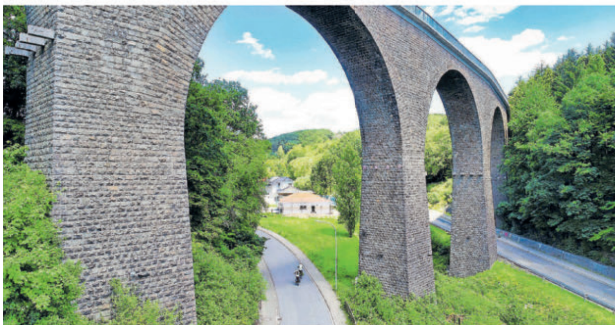
Die Talbrücke bei Oberkirchen.
