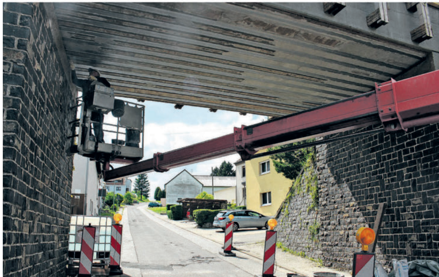
Die Brücken am Bahnradweg sind saniert worden. Foto: FRANK FABER
