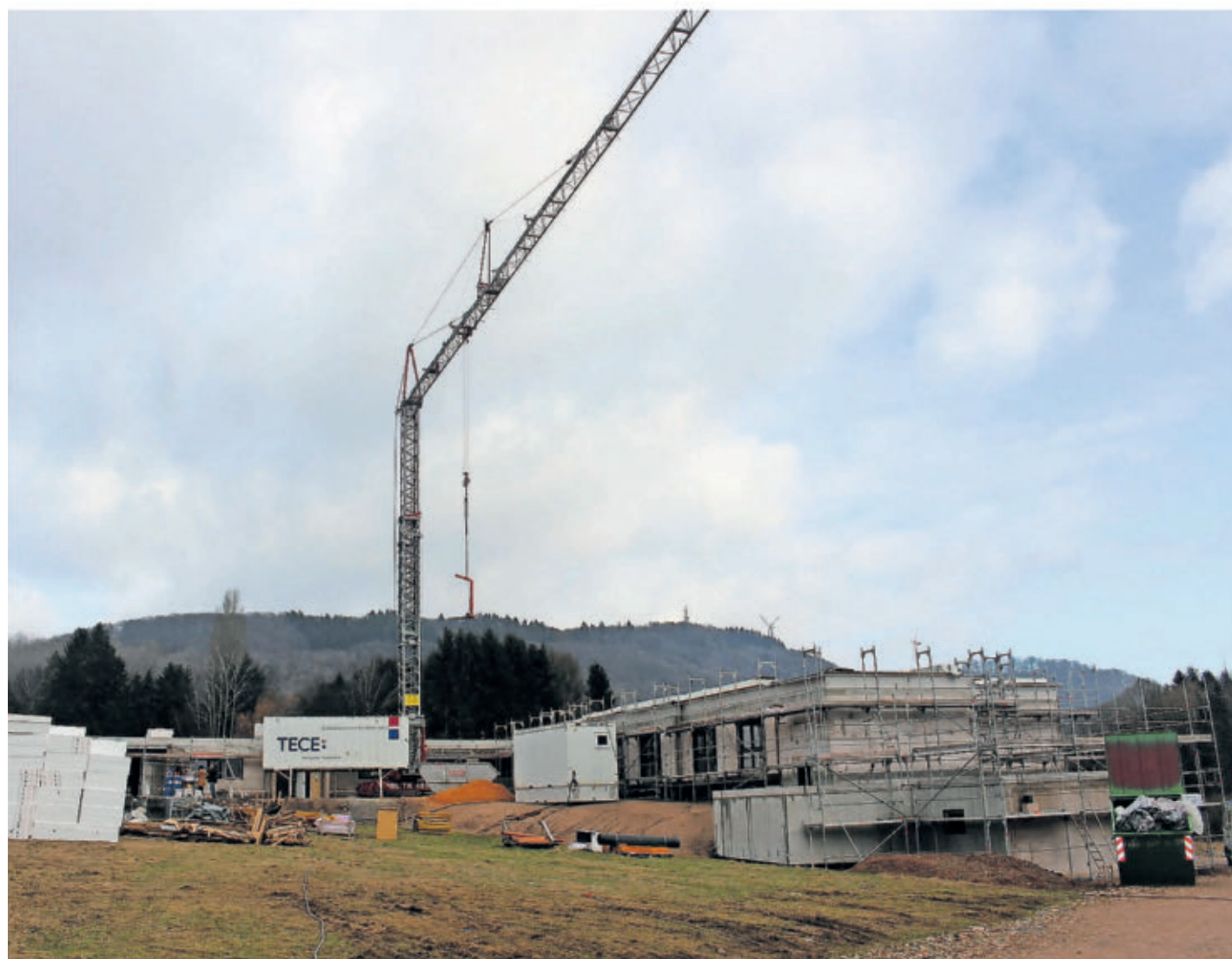
Der Rohbau steht, im Herbst soll das Seniorenzentrum in Oberkirchen eröffnet werden.
