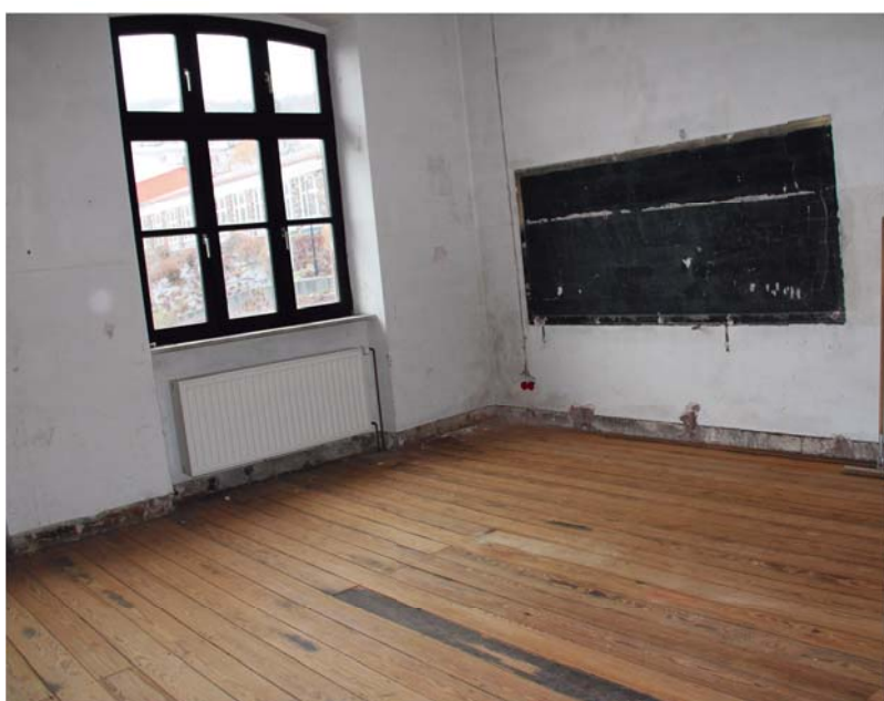
Dieser ehemalige Klassenraum wird zu einem Veranstaltungssaal umgebaut. Hier können auch Familienfeiern stattfinden.
